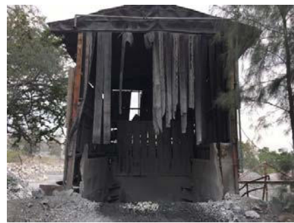
รูปที่ 2-16: การปิดคลุมถังรับหินใหญ่
