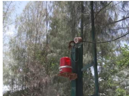
รูปที่ 2-12: หอสัญญาณเตือนการระเบิด
